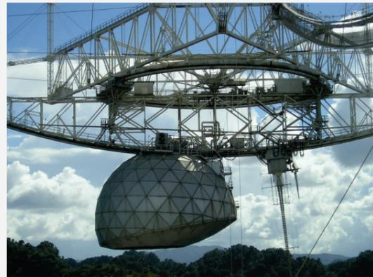
Die Instrumentenplattform des Arecibo-Radioteleskops besaß eine Masse von 900 t. (Foto: © Alessandro Cai, Wikimedia 2006)
